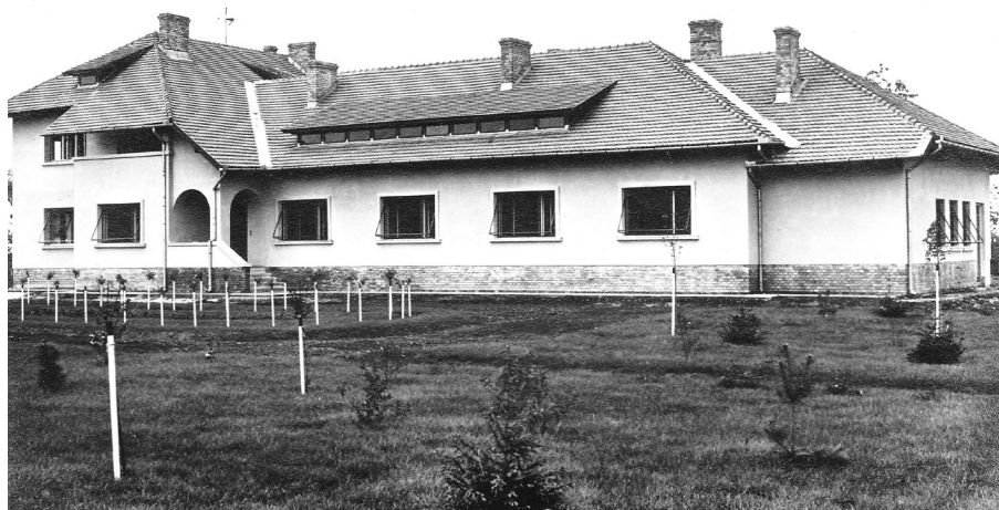
I.C.A.R. – Clădire administrativă.
